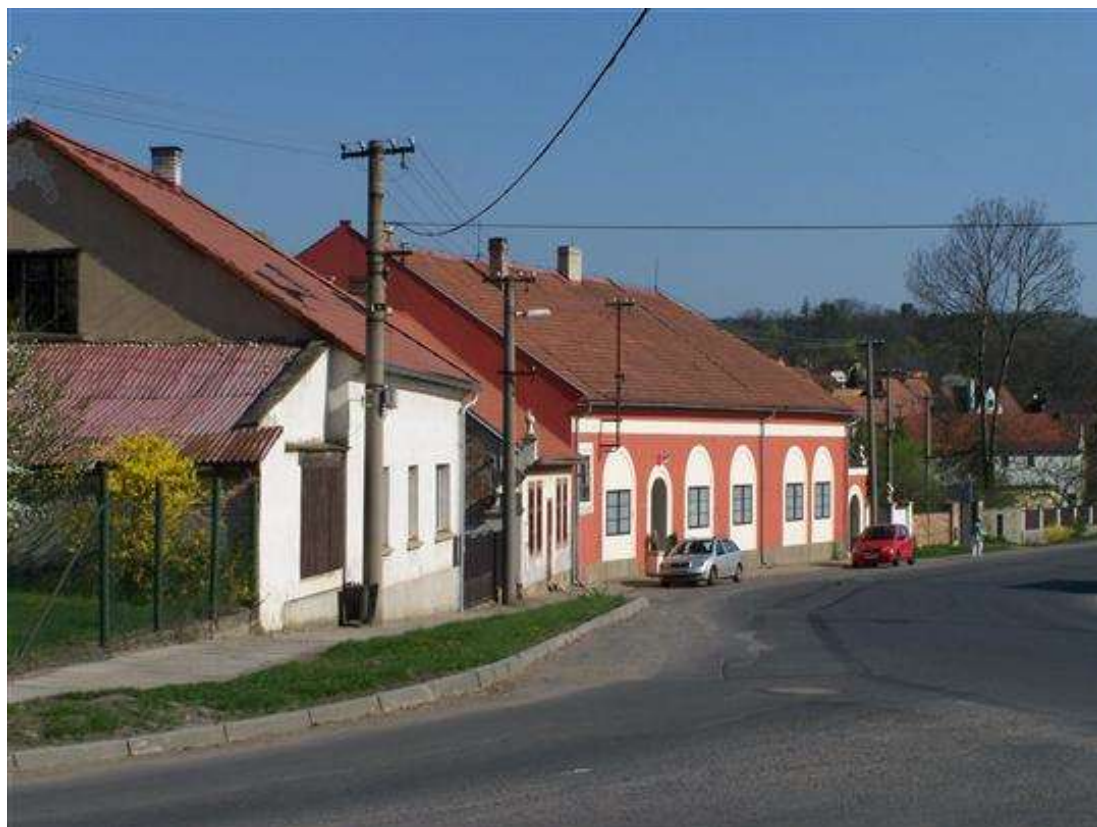
Křižovatka silnice od Podlešína (vlevo) s bývalou silnicí I/7
